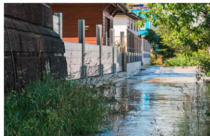
Der frisch eingerichtete Hochwasserschutz erlebte seine «Feuertaufe».
