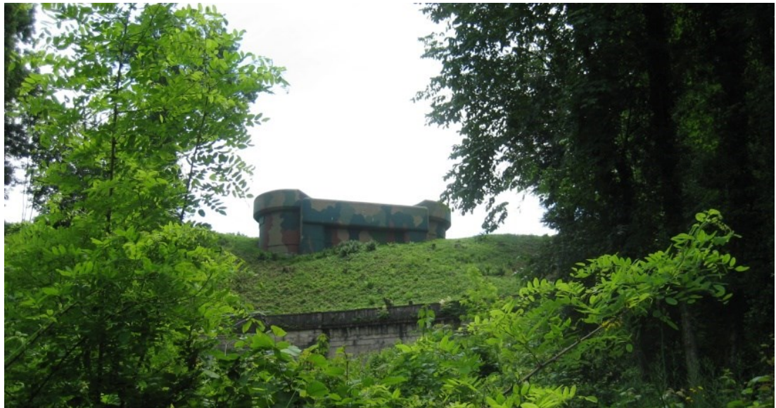
Abbildung 16: Bunker «Koblenz-Tunnel» 1937 (K10) / vorgelagert Tunnelportal 1859 (K9)
